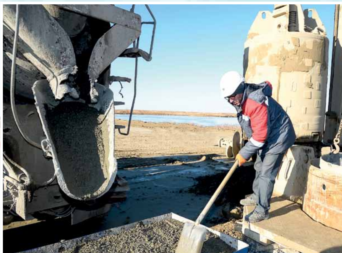
Ел тілегі ескерілді. Қазалыда «Әлсейіт» көпірінің құрылысы басталды.
